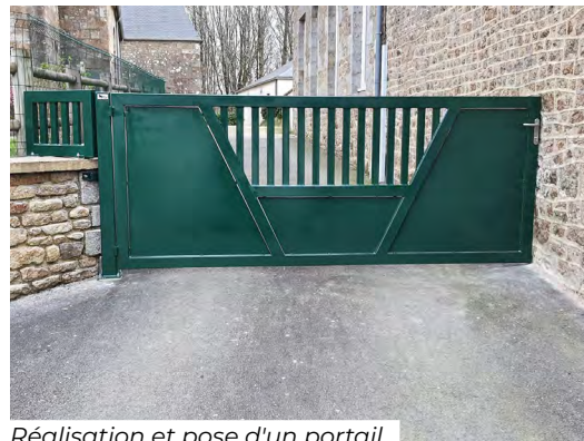
Réalisation et pose d'un portail
